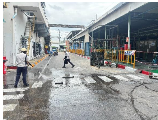
ภาพที่ 2-17 การทำความสะอาดและลอกตะกอน ในรางหรือท่อระบายน้ำฝน
